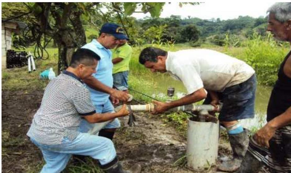
De la misma forma se realizó Mantenimientos de las bombas sumergible HIDROMATIC. Modelo S4K15.000M3 de la planta de bombeo de aguas servidas para evitar rebosamientos.
